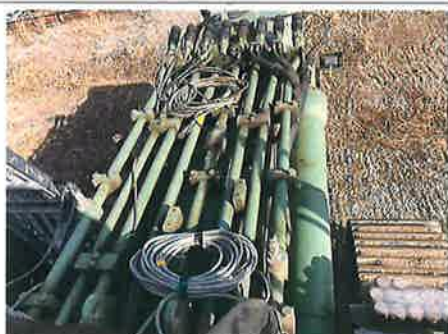
③：フロント 油圧配管・ホース
