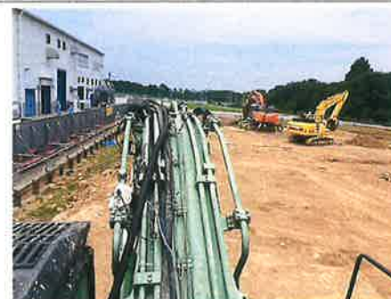
○：フロント 油圧配管・ホース
