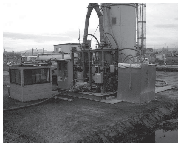
写真-1.2 改良材プラント
