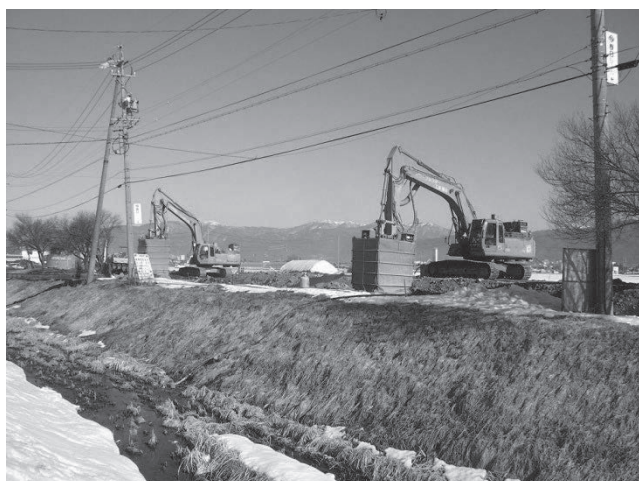
写真-1.1 施工状況
