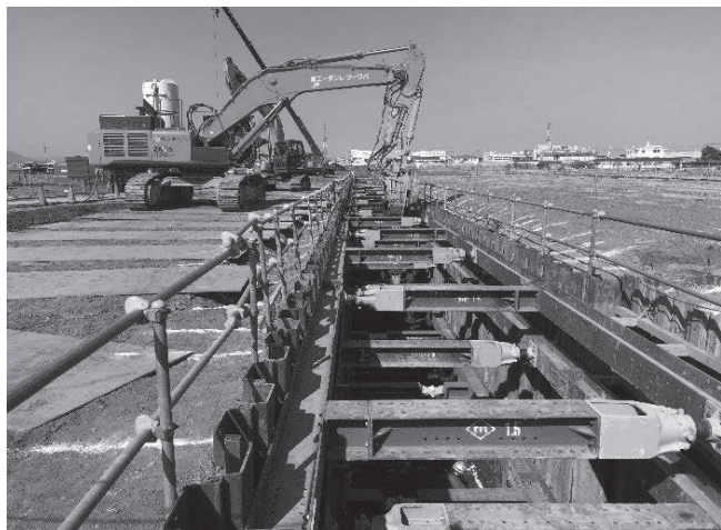
山留内での施工
