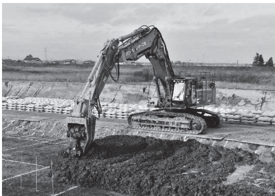
写真 3. 3-1 N 字施工攪拌混合状況
