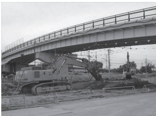
上空制限下での施工
