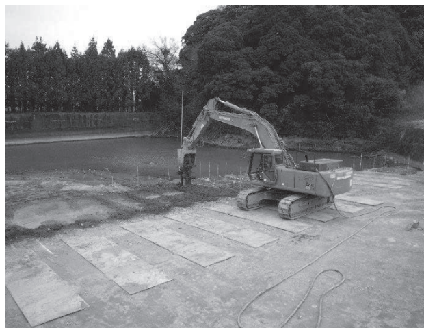
超軟弱地盤での改良による重機足場の拡張
