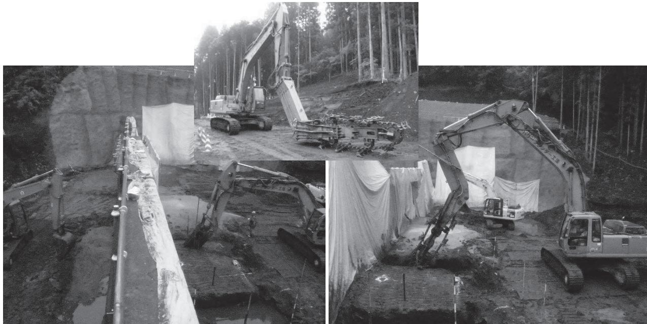
写真 3.1-1 水平トレンチャ及び施工状況
