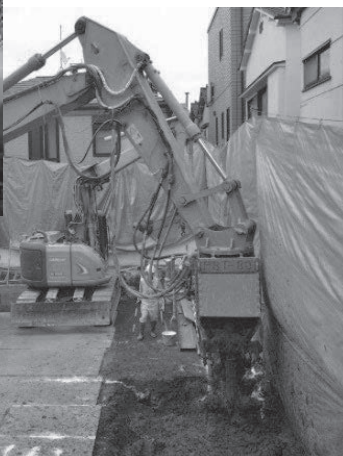
土留め壁構築の近接施工
