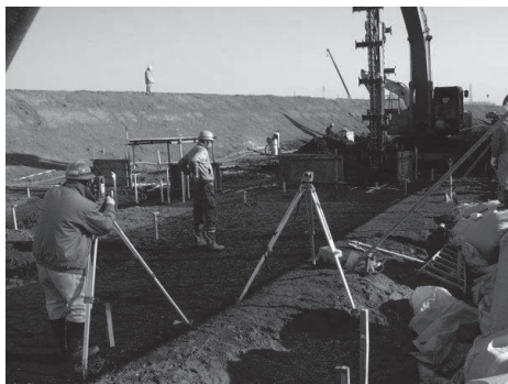
写真 4.1-2 地中変位測定状況
