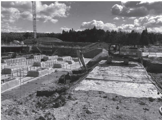
建築基礎の施工
