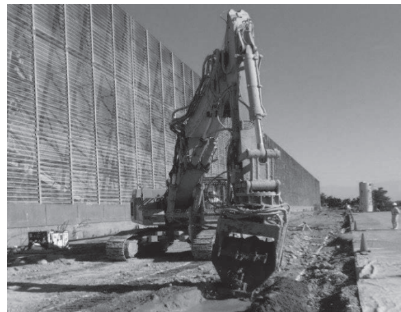
斜め土留め壁の構築
