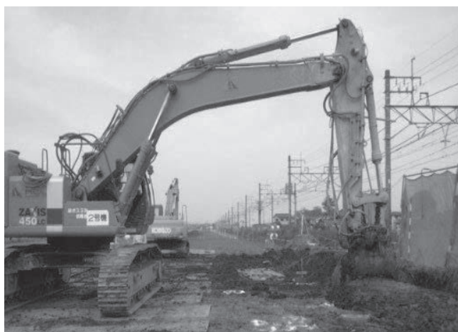
鉄道近接施工
