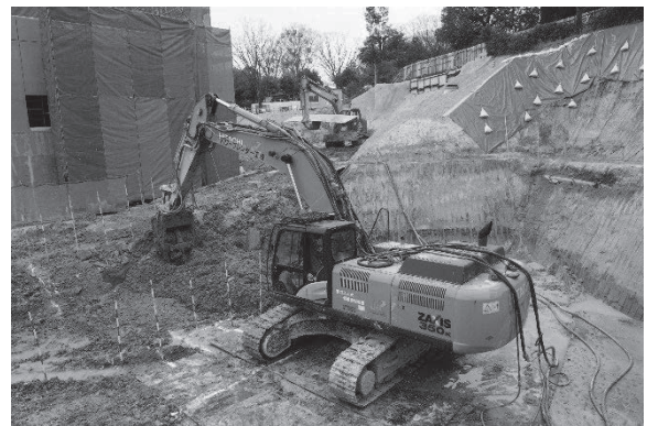
写真 3. 3-1 N 字施工攪拌混合状況
