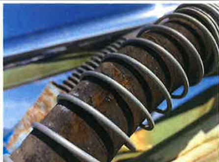
△：フロント 油圧配管・ホース
