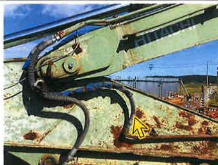
△：フロント 油圧配管・ホース
