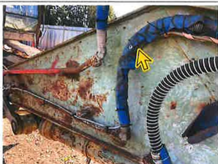
×：フロント 油圧配管・ホース
