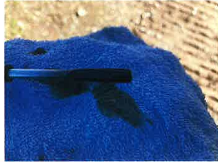
△：上部旋回体 ポンプ装置
