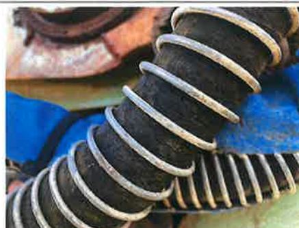
△：フロント 油圧配管・ホース
