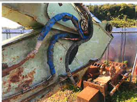
△：フロント 油圧配管・ホース
