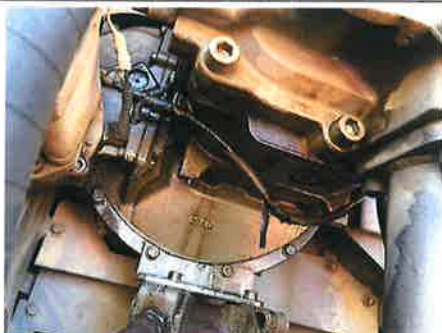
△ : 上部旋回体 ポンプ装置
