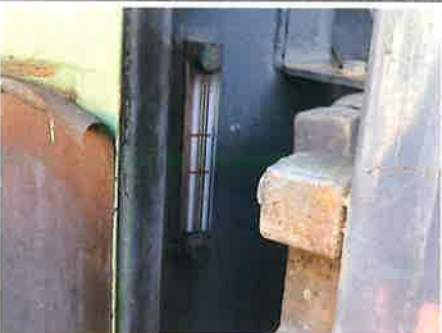
△ : 上部旋回体 作動油タンク・作動油
