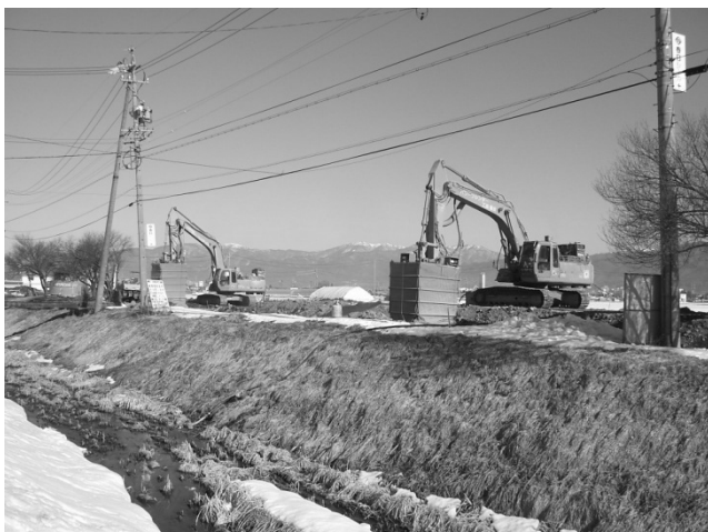
写真-1.1 施工状況
