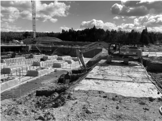
建築基礎の施工
