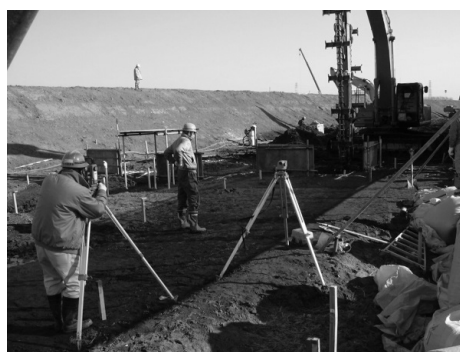
写真 4.1-2 地中変位測定状況
