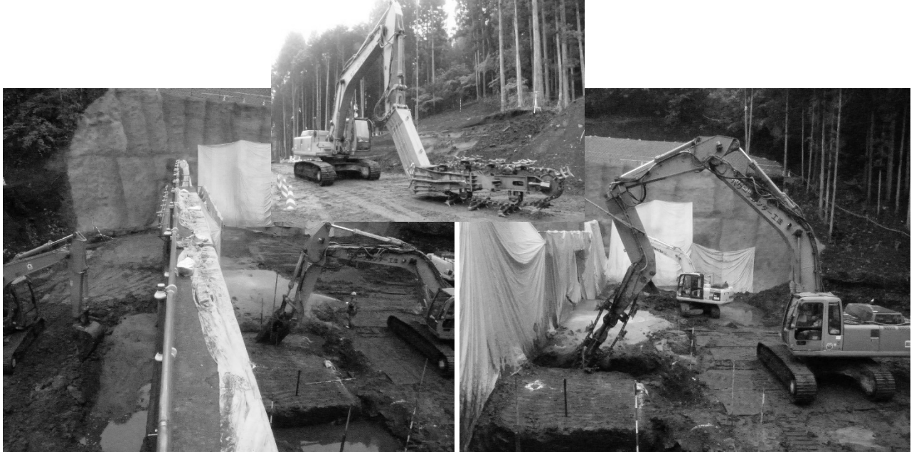
写真 3.1-1 水平トレンチャ及び施工状況
