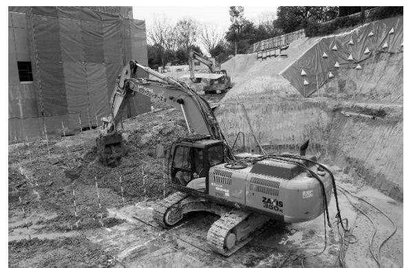
写真 3.3-1 N字施工攪拌混合状況
