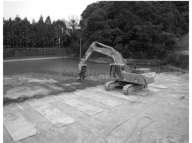
超軟弱地盤での改良による重機足場の拡張
