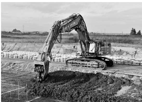
写真 3.3-1 N字施工攪拌混合状況
