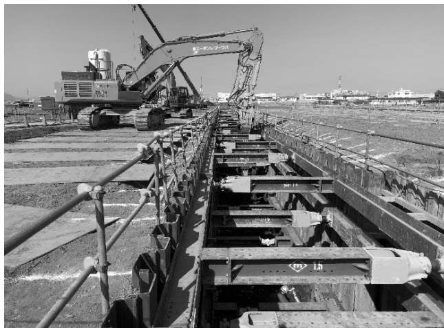
山留内での施工
