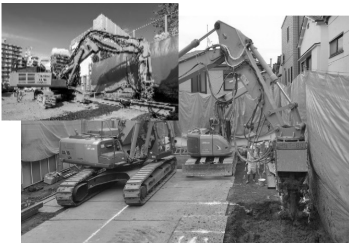
土留め壁構築の近接施工
