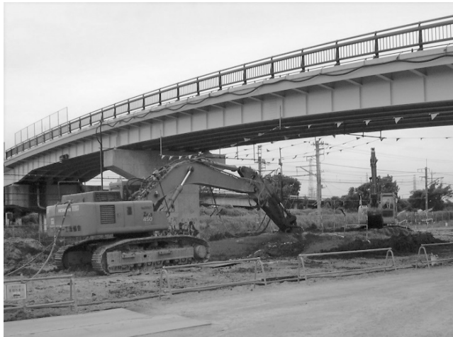
上空制限下での施工
