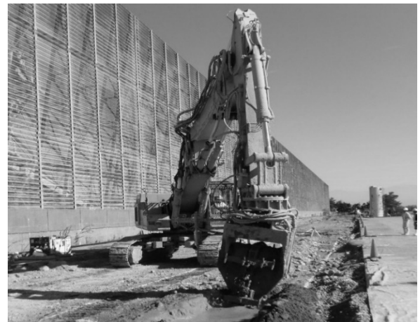
斜め土留め壁の構築
