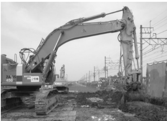
鉄道近接施工
