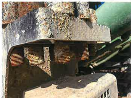
× : 下部走行体 トラックリンク
