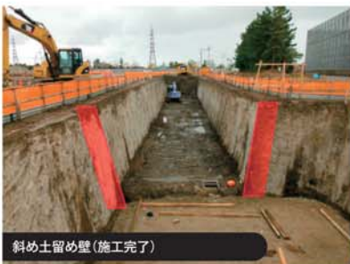
斜め土留め壁 (施工中)
