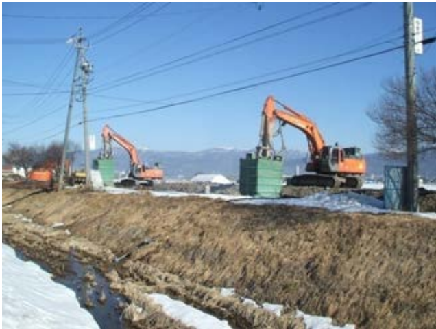
写真-1.1 施工状況
