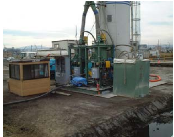
写真-1.2 改良材プラント
