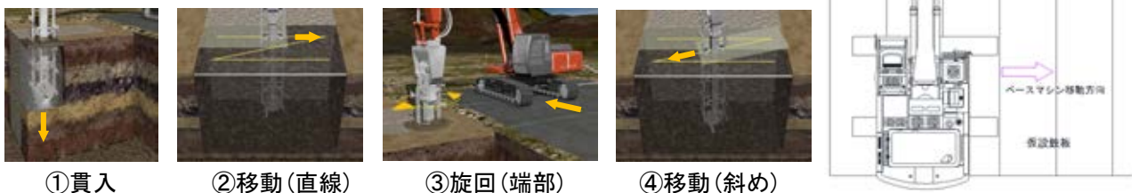
図 1.3-2 標準施工図
