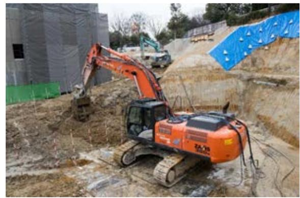
写真 3.3-1 N字施工攪拌混合状況
